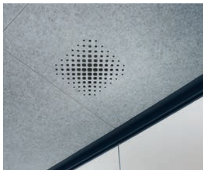
L'air frais est aspiré dans la pièce par un silencieux invisible, intégré au plafond acoustique
