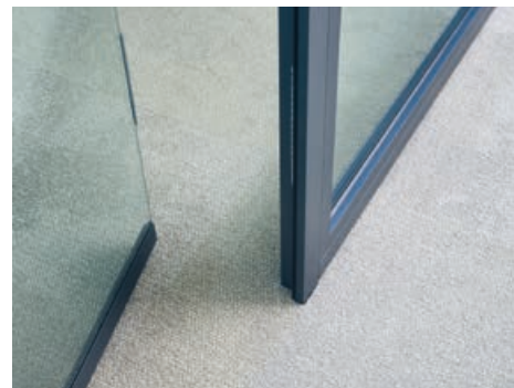
se:cube max est posé sans plancher sur le sol du bâtiment. Sans seuil de porte, il reste accessible en fauteuil roulant
